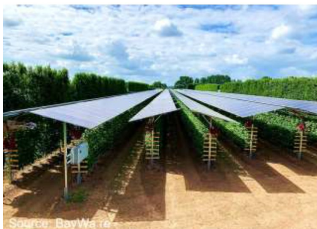
Illustration d'un système de production de petits fruits sous panneaux photovoltaïques (source : système BayWa r.e.)
